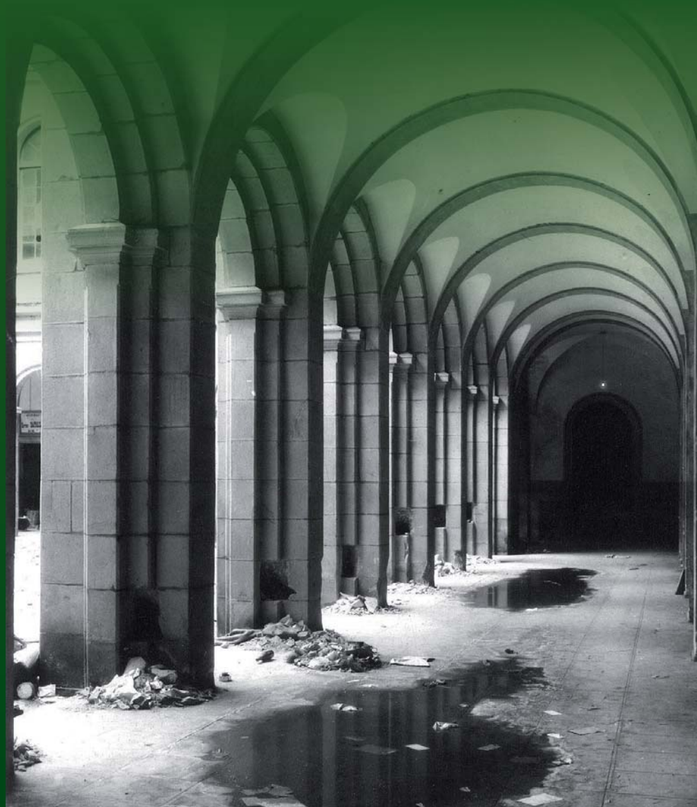
Claustro con las columnas perforadas para rellenarlas con dinamita
